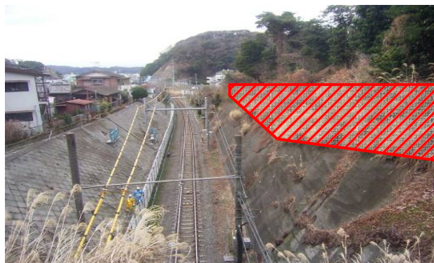
写真-1 施工前全景
