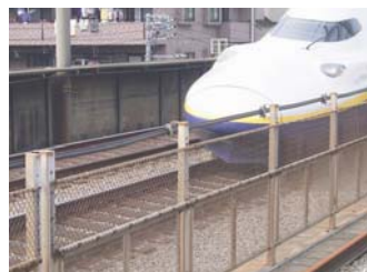
図1 LCX ケーブル設置状況
