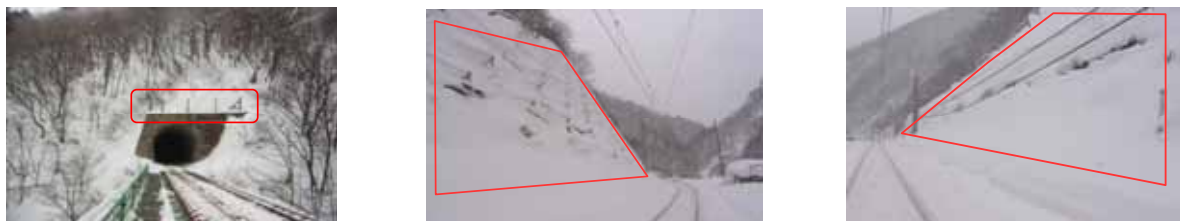
図-4. 『雪底点検マニュアル』に掲載した点検箇所の写真
