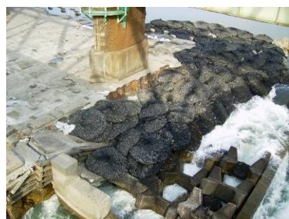
写真-3 フィルターユニット設置
