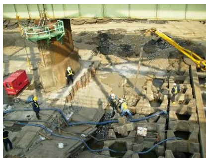
写真-4 コンクリート打設
