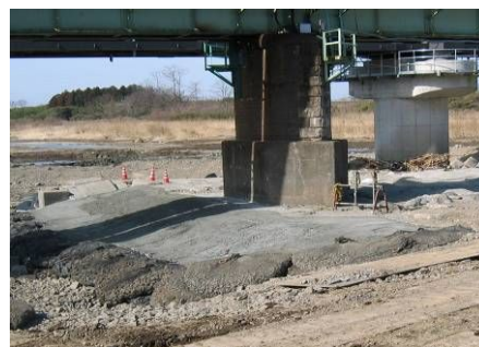
写真-5 対策工完了
