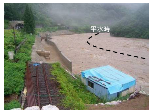
写真-5 平成18年7月の河川増水時
