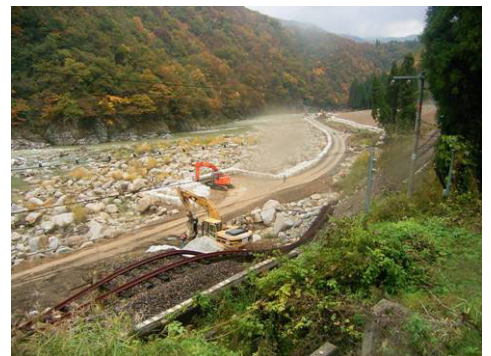
写真-2 工事用道路・作業ヤードの施工
