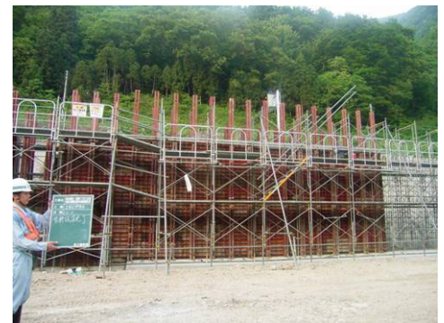
写真-4 鋼製型枠を用いた打設
