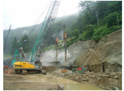
写真-3 仮土留め工の設置
