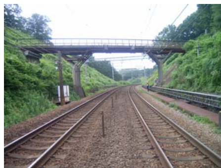
写真1 古レール造跨線橋
