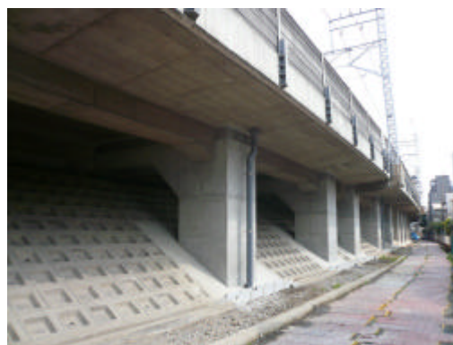
写真-1 完成写真
