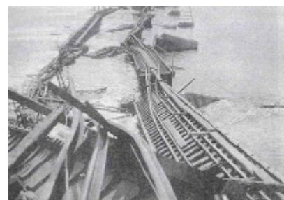
写真2 橋脚の転倒・崩壊 1)
