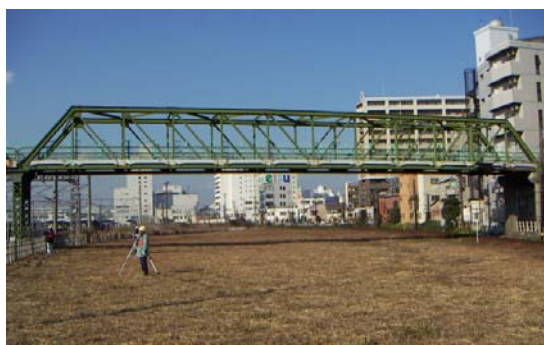
写真-2 東側既設トラス橋
