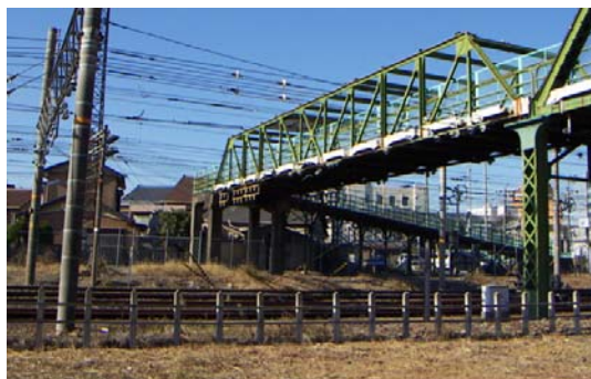
写真-1 西側既設トラス橋(線路上空部)
