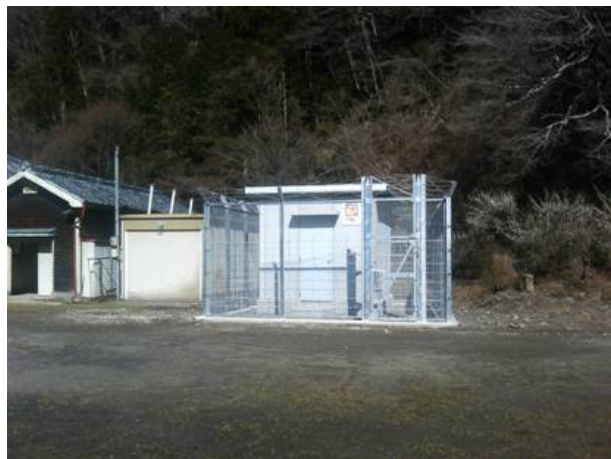
図5 増設遠方地震計外観
