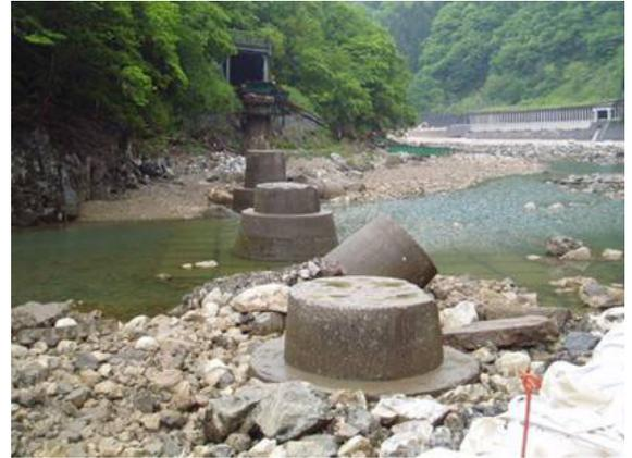
写真-1 倒壊した第9宮川橋梁
