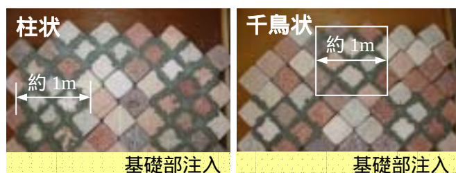
図 - 1 目地接着施工形状模式図
