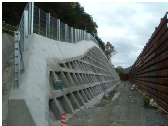
図1 施工後の様子（第3工区）
