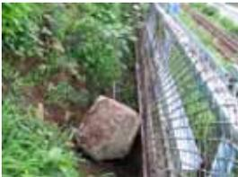
写真 - 1 捕捉された落石
