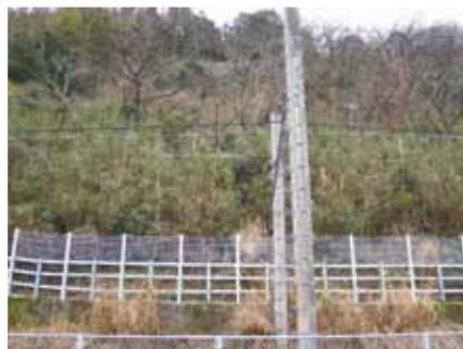
写真 - 5 落石止柵の嵩上げ
