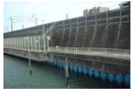
写真-1 護岸鋼矢板の防食対策（青い部分）
