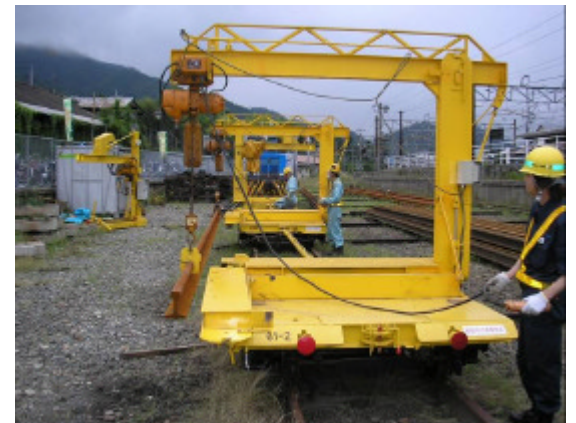
写真-5 台車左側へのレール取卸し
