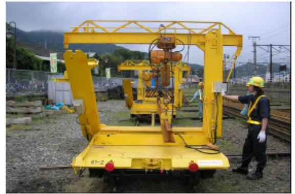
写真-4 左支柱の倒し
