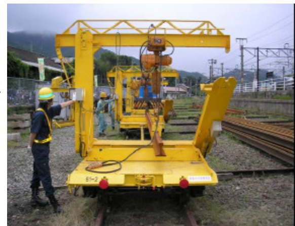
写真-3 右支柱の起し
