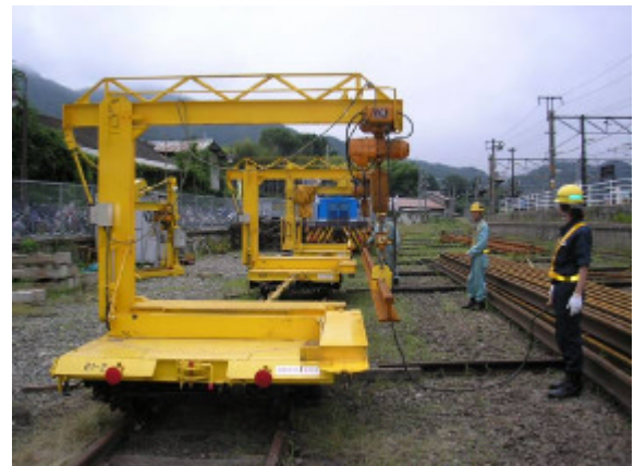
写真-2 台車右側からのレール積み込み
