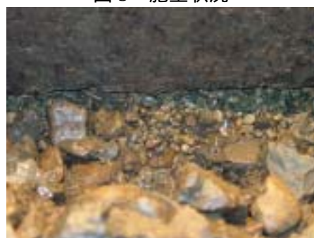
図4 施工後のてん充状況
