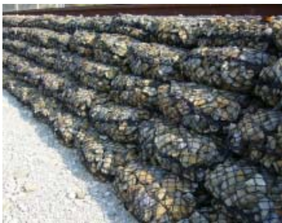
図1 バッグ敷設状況
