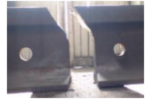
写真-1 シェリング傷によるレール折損
