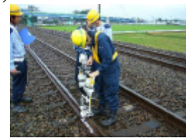
写真-4 現地における探傷検査の様子
