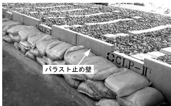
図3 バラスト止め壁
