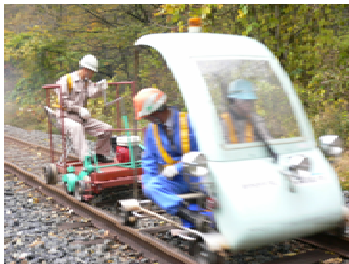
図-5. 落葉除去装置によるレール研磨
