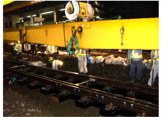
写真-1 施工状況（鉄道クレーン使用）
