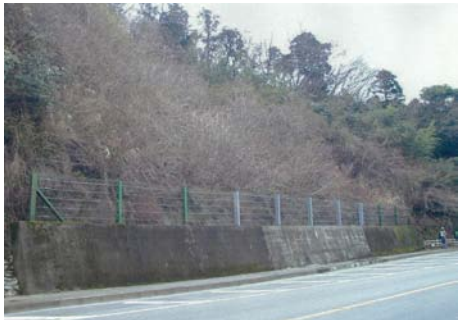
落石防護柵・擁壁
