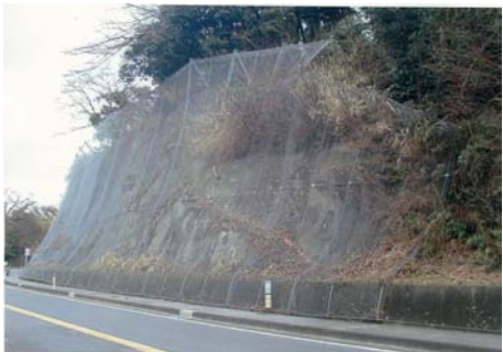
吹付工・落石防護柵・擁壁
