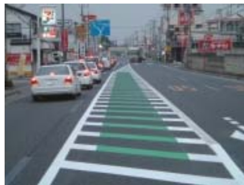
図-7 右折待ちレーンの設置状況
