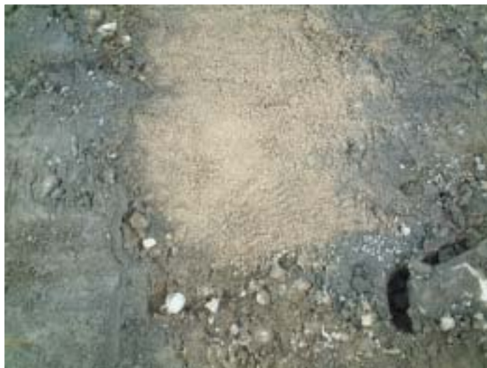
写真 2 打設後の SCP 杭
