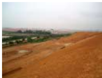
写真-3 処分場法面(覆土後)
