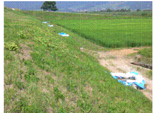
図一 3 月輪工の様子（右岸 31.3km）
