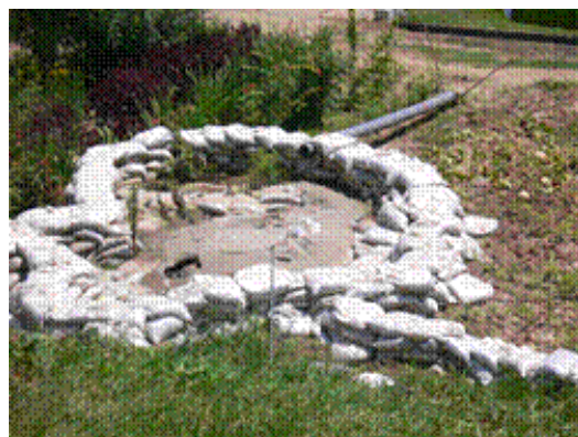
図一 2 噴砂の状況 (右岸 59.0km)
