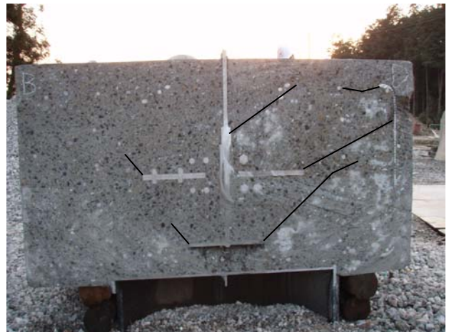
写真－3 供試体切断面（供試体 2）
