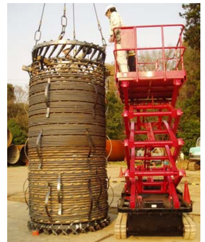
写真-3 縮小状態の鉄筋かご
