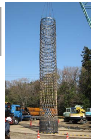
写真-2 鉄筋かごの伸縮
