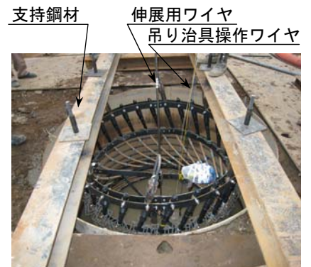
写真-4 伸展建込み状況
