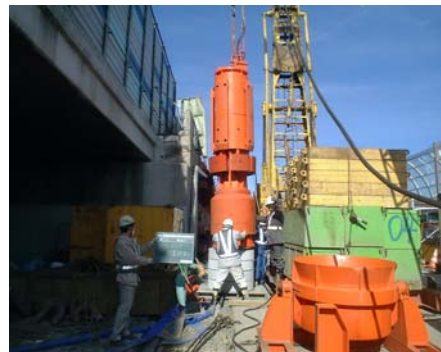
写真-1 貫入機設置状況
