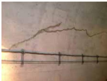
写真2 水平ひびわれ状況(補修済)
