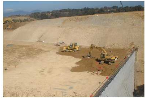
写真-1 一般部の施工状況
