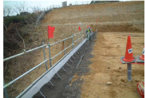
写真-2 壁面傍での施工状況
