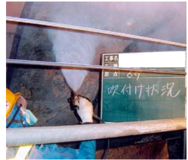
写真-1 樹脂吹付け状況
