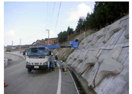
写真-2 高所作業車による作業状況
