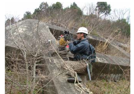
写真-6 設置・試験状況
