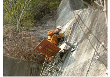
写真-4 設置・試験状況
