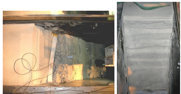
図-5 セメント材料模型の崩壊状況(左:実験直後の崩壊の様子,右:崩土除去後)
