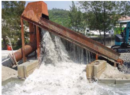
写真－3 土砂分離機
