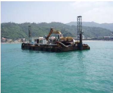
写真－1 浚渫全景
