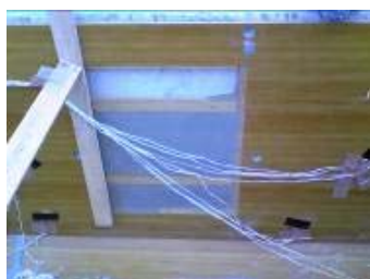
写真-4 側面充填状況
