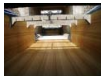
写真-2 FFUトラフ改修事例
