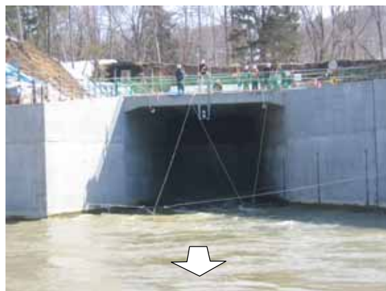
写真-2 開口部末端流速の計測状況
