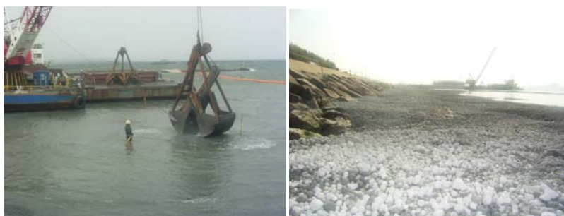
写真-2 浅場造成施工状況
