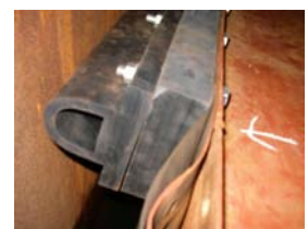
写真 3. バッファの取付け
