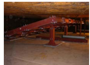
写真 1. タンク内に設置した造波装置
