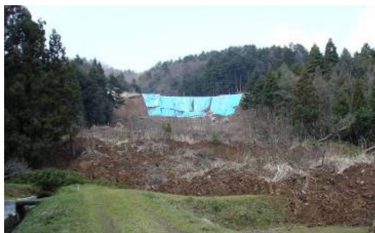
図5 崩壊現場南側より撮影
