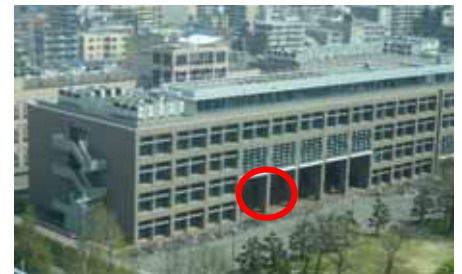
写真-1 大阪市立大学 全学共通教育棟全景
