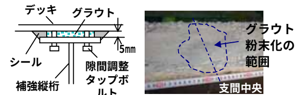
図4 補強縦桁グラウトの状況
