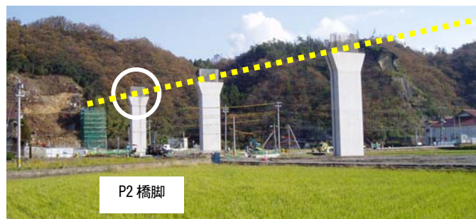
写真-1 調査橋脚
