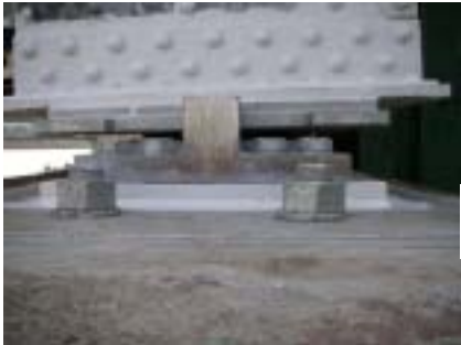
図-6 取替後の支承構造
