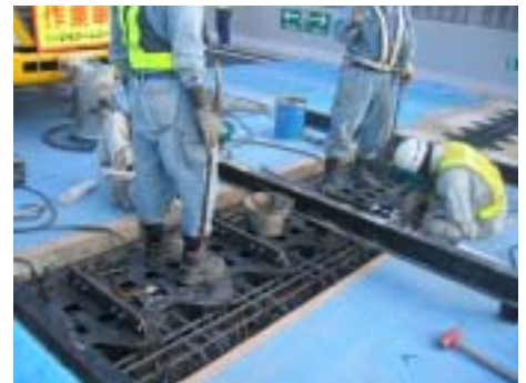
写真 2 伸縮装置の取替え工
