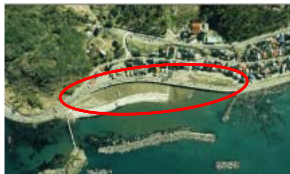
写真1 弁天大橋全景航空写真
