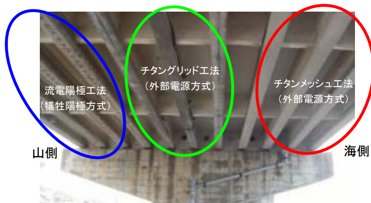
写真2 適用された電気防食工法と対象桁(第8径間)
