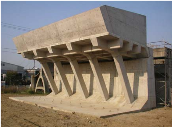
写真-1 落石防護棚の実験供試体
