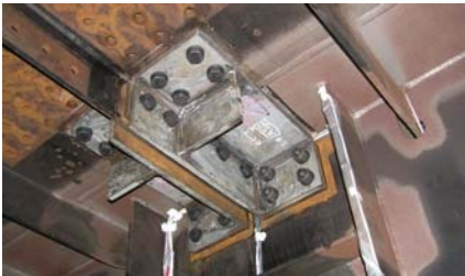
図1 鋼製橋脚横梁における当板補強例
