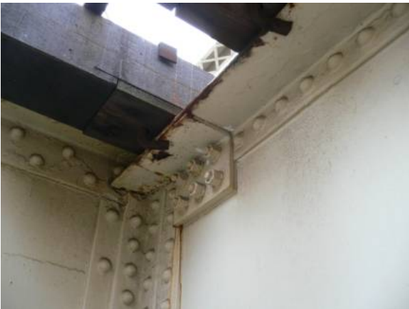
①き裂部分への当て板＋高力ボルト補修
