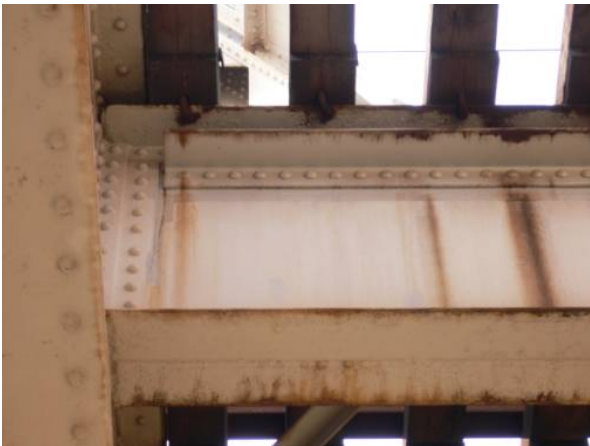
②上フランジ直下へのL型鋼取り付け
